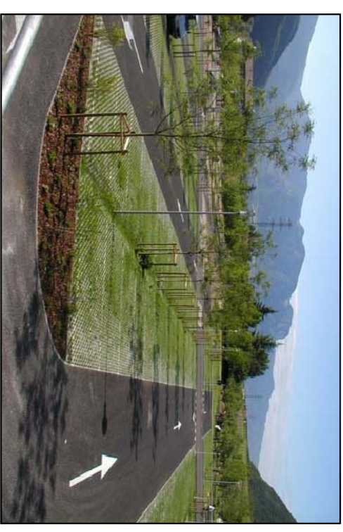
Esempio di pavimentazione semipermeabile per parcheggi
